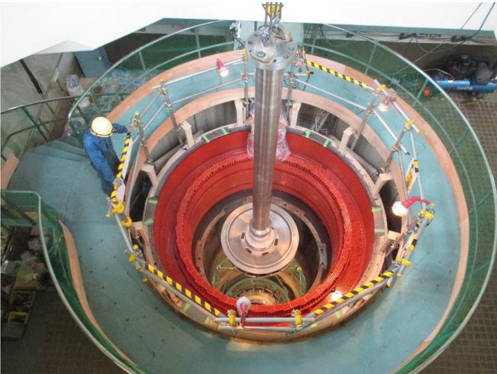
水を効率よく使うため、固定部と回転部の隙間は1mmしかありません。慎重に慎重に吊り込みます。
