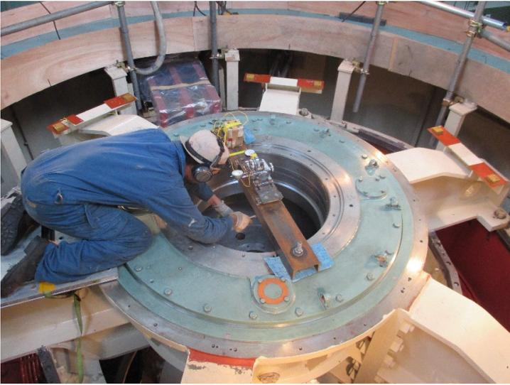
インサイドマイクロメータを使って精度の高い組み立てを熟練の腕で・・・
