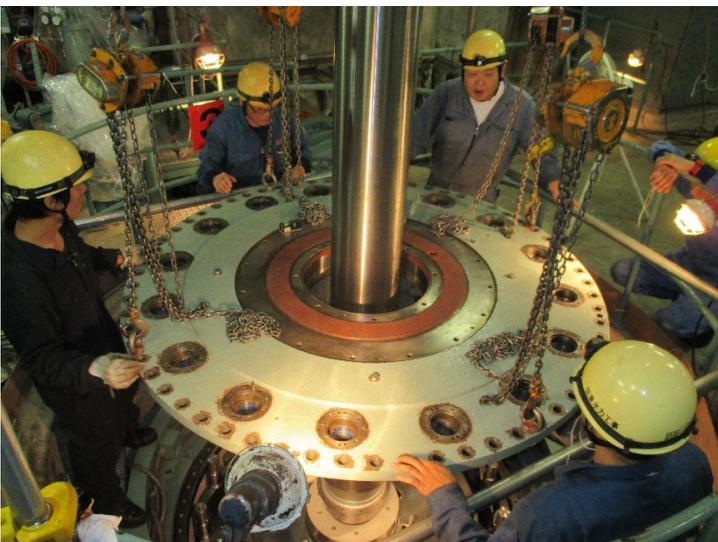
水車カバーの吊り込みです。みんなで声を掛け合って水平に吊り込みます。チームワークが大切です。
